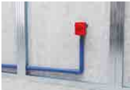
2. Připojit odtokové potrubí.
